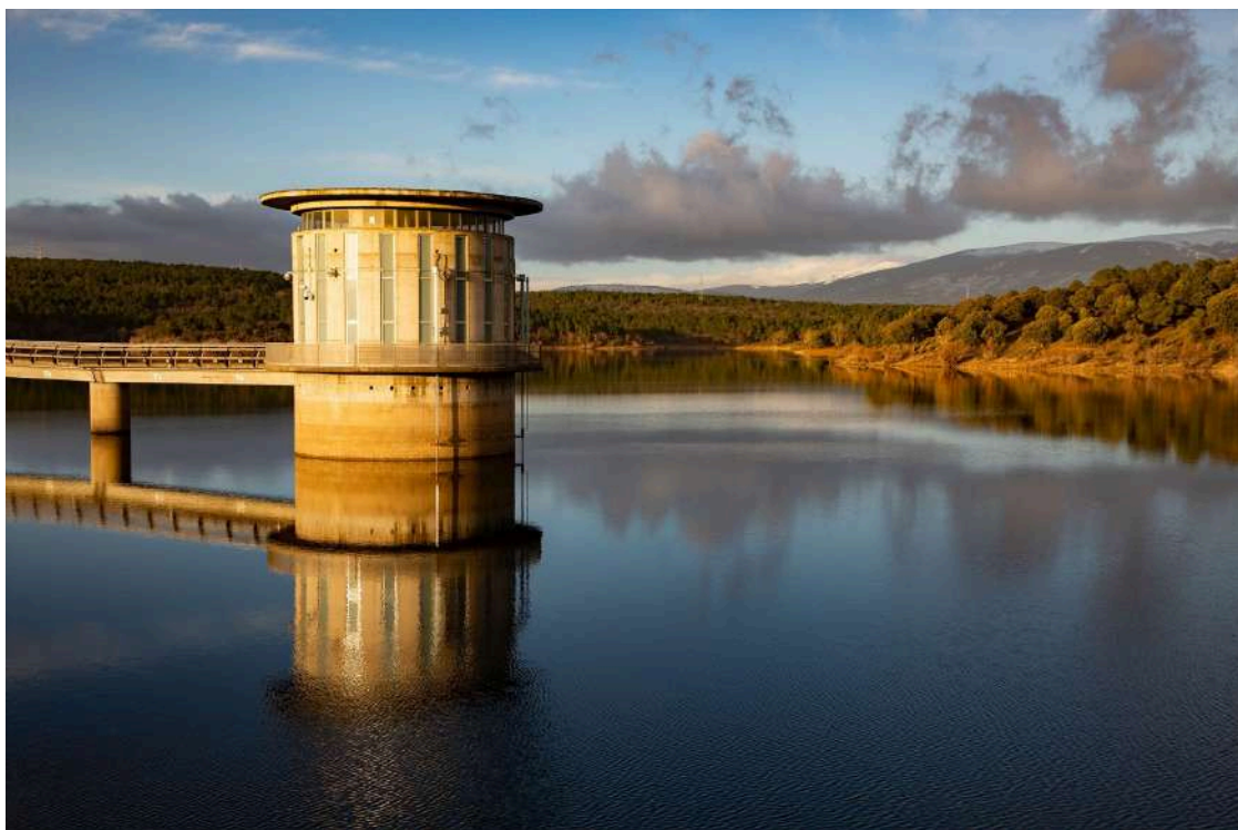
La presa de Puentes Viejas (Canal de Isabel II)
