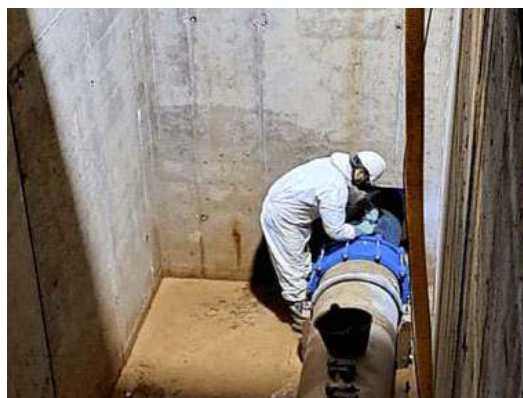
Un operario, trabajando en uno de los tramos de la red. / LT
