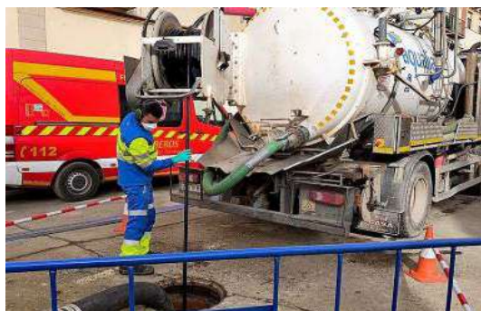
Operarios de Aqualia realizan catas en el alcantarillado de la ciudad. / MANU REINO
