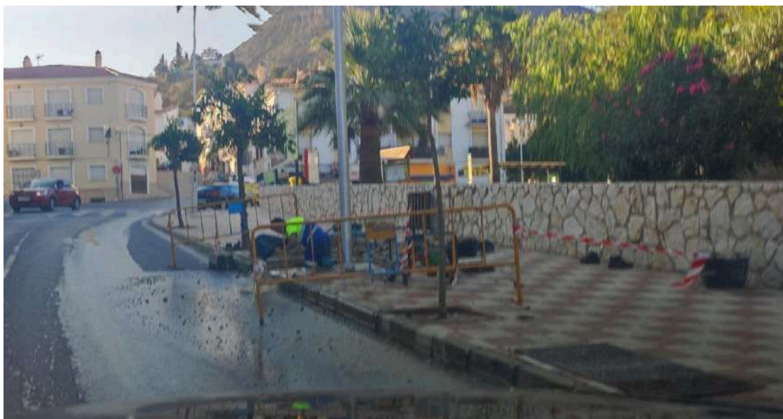
Operarios de Aqualia trabajan para reparar la avería en la red de abastecimiento en la zona de Santo Cristo.
